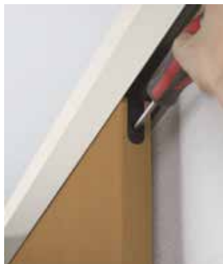
前後調整門片與門框的距離。 (前後+-2mm)
