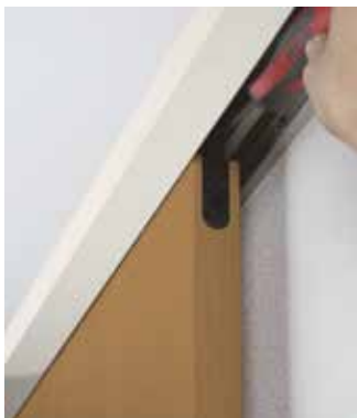
上下調整與地面及滑軌的距離。 (上3mm、下2mm)
